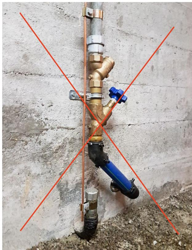
Così non è corretto: ponte elettrico di superamento per la messa a terra sulla vecchia condotta di alimentazione esistente
