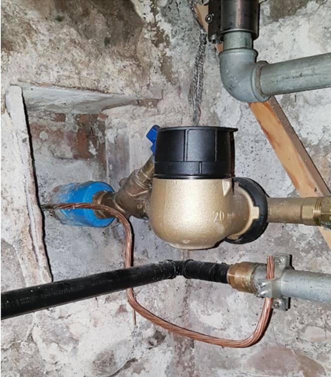
Messa a terra sostitutiva sulla condotta dell'acqua dopo sostituzione della condotta di allacciamento dell'immobile
